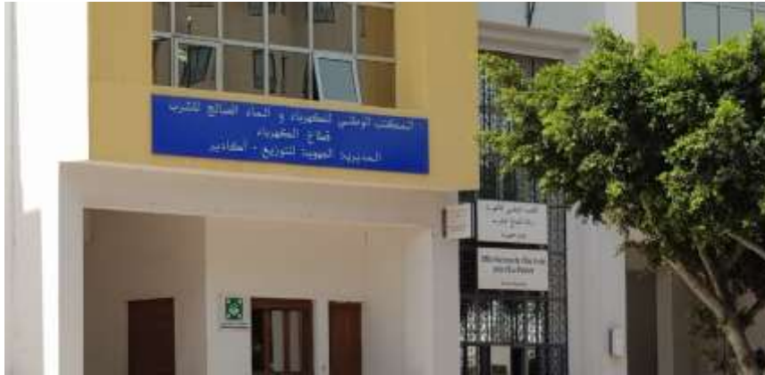
Photo 6 : Siège de l'ONEE Branche Electricité
