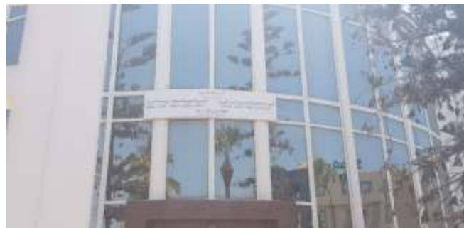
Photo 10 : Siège de l'Inspection Régionale de l'Urbanisme et de l'Aménagement du Territoire
